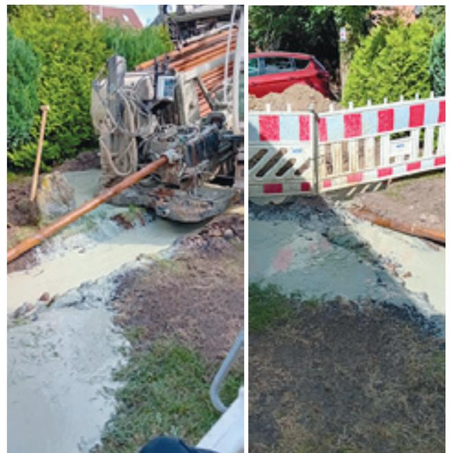
Was sehr stark an die Bau- bzw. Bohrarbeiten im Rahmen des Breitbandausbaus vor einigen Jahren erinnerte, entpuppte sich als vorbereitende Bohrung für das Verlegen neuer Stromkabel durch die Schleswig-Holstein Netz AG. Im Zuge der Optimierung und Verbesserung der Versorgungssicherheit tauscht die SH Netz AG nicht nur Freilandleitungen gegen Erdkabel aus. Nein, wir bekommen Ersatz
