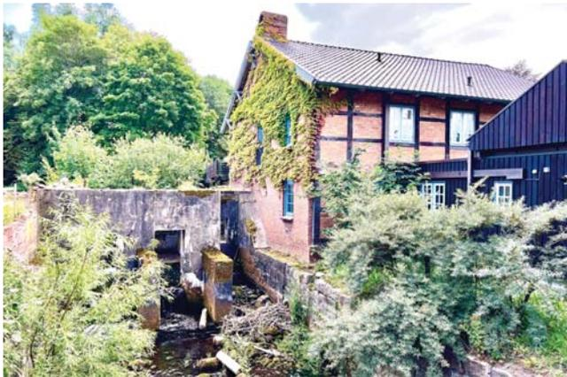
Das Stauwehr diente der Mühle und dem Elektrizitätswerk
