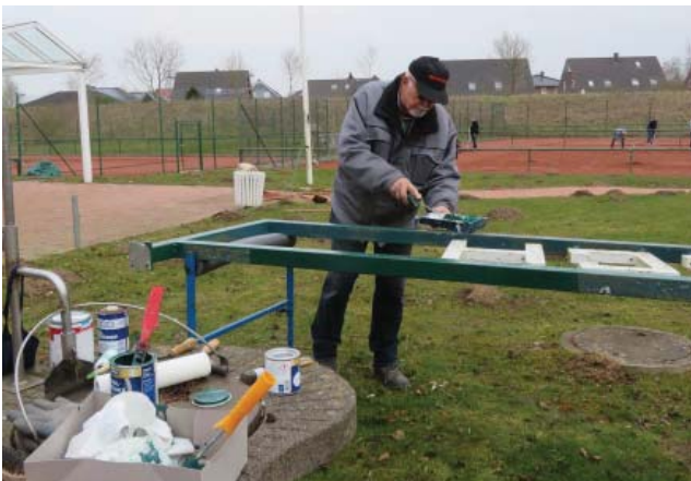
das Tor zur Einfahrt von Harry Kielmann gestrichen und am zweiten Wochenende aufgestellt..
