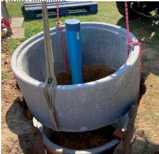
Der Brunnen ist fertig, die Schachtringe werden aufgesetzt
