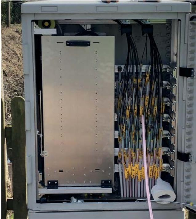
Das zweite Foto zeigt das Innenleben eines der vier Verteilerkästen in unserem Dorf. Jedes Röhrchen gehört zu einem Hausanschluss. Und wenn man ganz genau hinguckt, kann man vielleicht schon ein paar kleine Bytes erkennen, wie sie sich durch das Glasfaserkabel schleichen..... 😊
