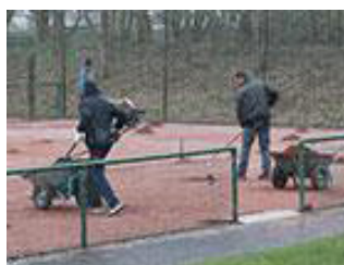
Mitarbeiter der Firma „Kates“ bei der Arbeit (bei einem kräftigen Hagelschauer)
