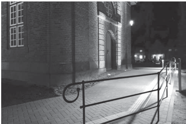
Der barrierefreie Eingang für die Winterkirche ist fertig und auch in der Dunkelheit gut erkennbar.
