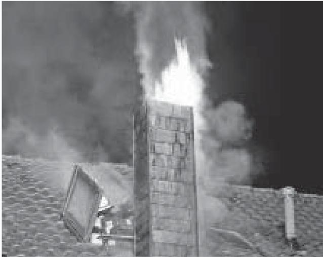
Schornsteinbrand? Ein Schornstein kann eigentlich nicht brennen. Was in einem Schornstein brennt sind überwiegend Rußablagerungen an den Wänden des Kamins. Dabei bildet sich der sogenannte Glanzruß, der, wenn er brennt, eine Temperatur von bis zu 1400° C erreichen kann. Dabei besteht für das ganze Gebäude eine erhöhte Brandgefahr.
