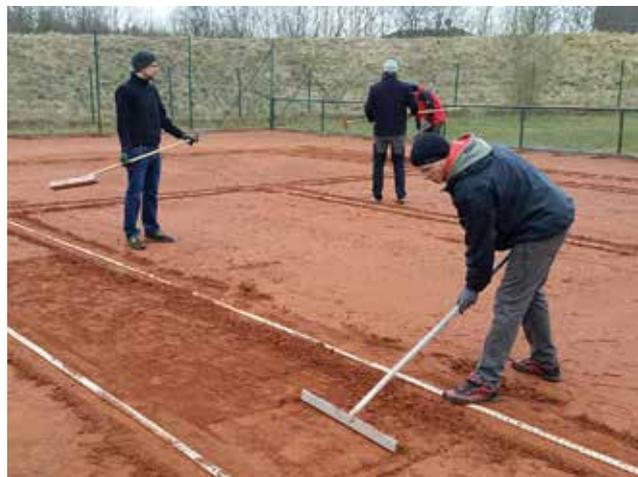
Der alte Ziegelmehlbelag muss von den Plätzen entfernt und wieder neu aufgebracht werden
