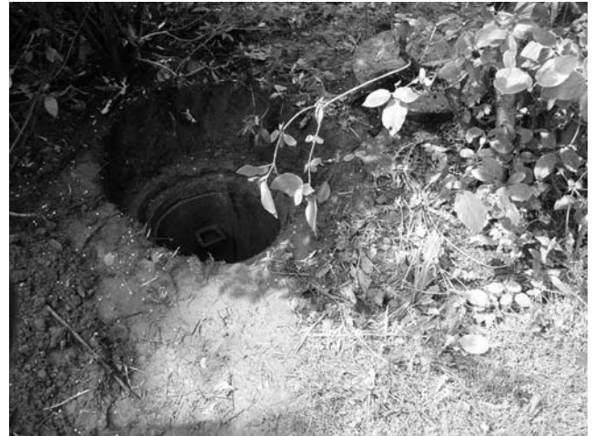
Der vergrabene Kontrollschacht
