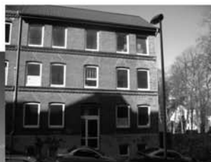
Mehrfamilienhaus in Kiel
