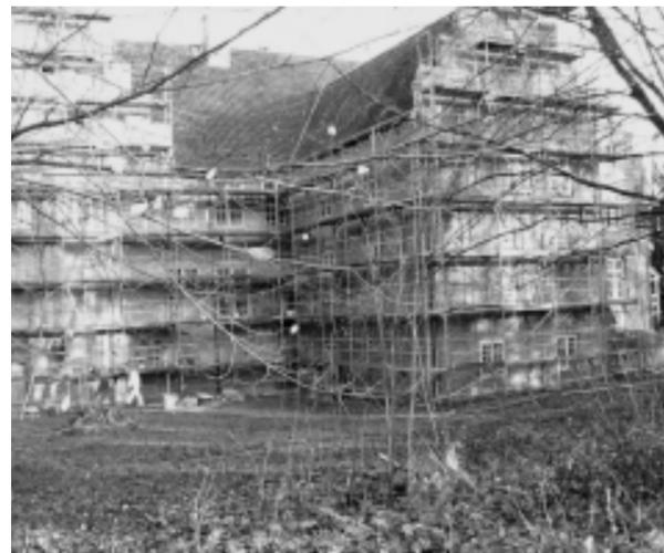
Neben den Hauptgewerken wurden bereits im ersten Abschnitt der Fassadensanierung größere Titandachrinnen und Fallrohre angebaut. In der Vergangenheit kam es oft zu Problemen bei der Dachentwässerung, die dann zu Durchfeuchtungen in den verschiedensten Bereichen geführt haben. Auch wurde das Vorhandensein des Gerüsts genutzt, um die vorhandenen Gussfenster und Maueranker zu streichen
