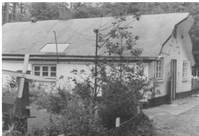
Einer der typischen Bunker im „Hagener Moor“
