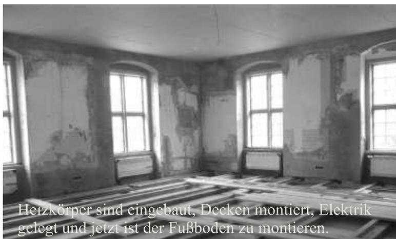
Heizkörper sind eingebaut, Decken montiert, Elektrik gelegt und jetzt ist der Fußboden zu montieren.
